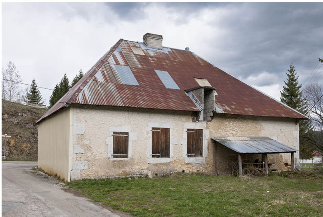
Façades postérieure et latérale droite en 2016.
