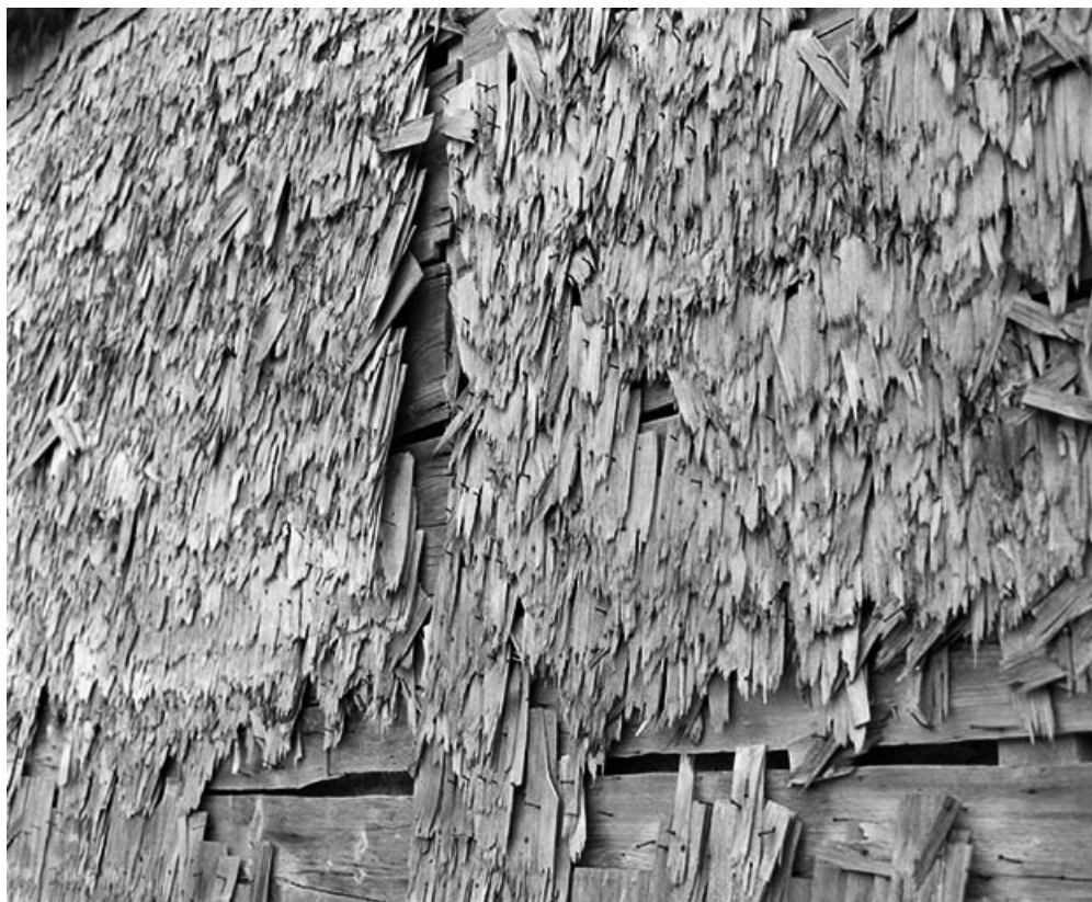
Tavillons de la façade latérale droite.
