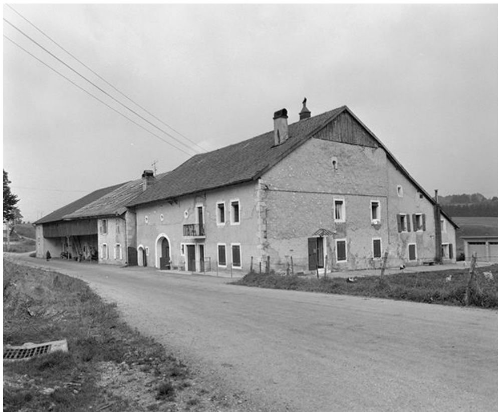
Ferme Villedieu-les-Rochejean : vue de trois quarts droit. 25, Les Villedieu
