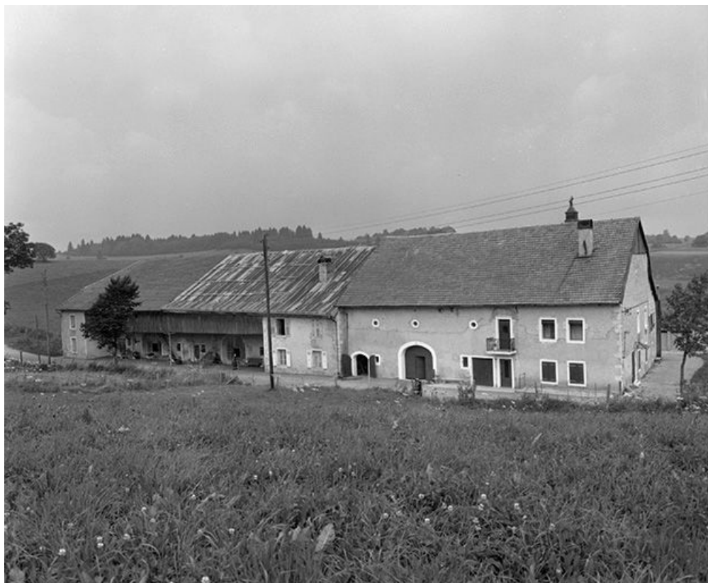
Ferme situées à Villedieu-les-Rochejean : façades sur rue. 25, Les Villedieu
