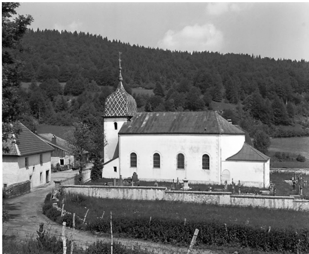
Façade latérale droite.
