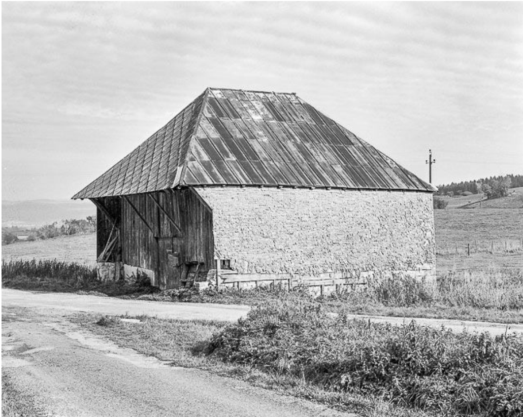
Bâtiment servant de remise.
