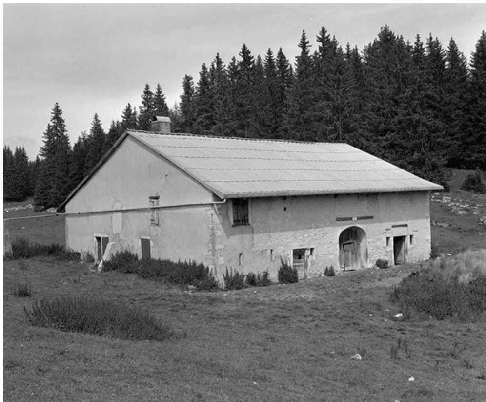
Façades antérieure et latérale gauche.
