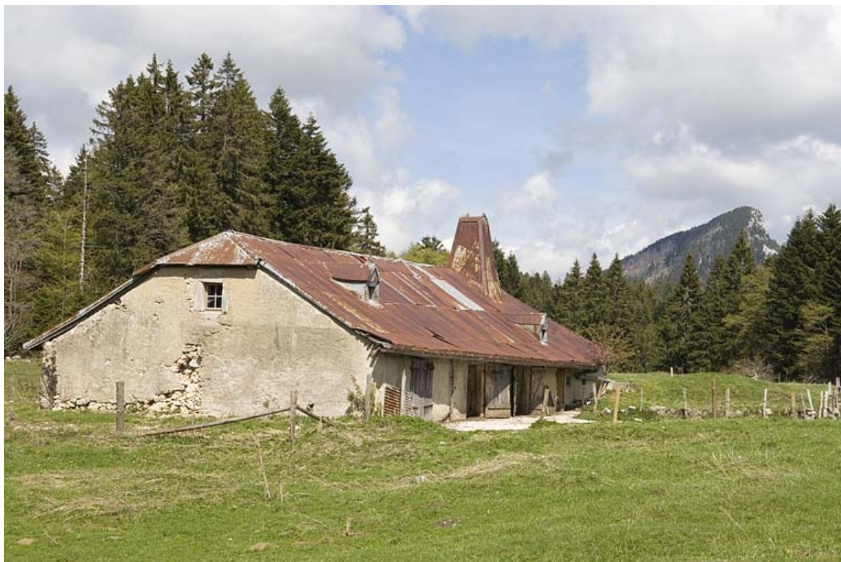
Vue générale de la Bécasse et de l'Aiguillon de Baulmes.
