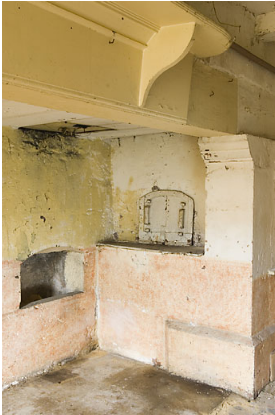
Cuisine du 1er étage : four à pain et cendrier. 25, Jougne, 17 rue du Faubourg
