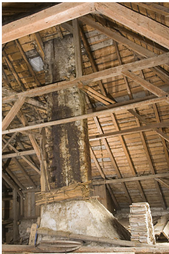
Grange : conduit de cheminée.
