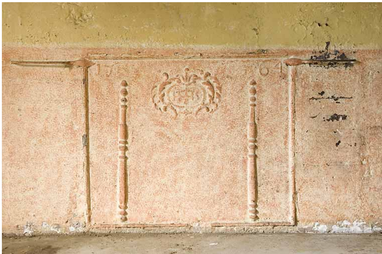
Cuisine du 1er étage : plaque de cheminée datée 1764.
