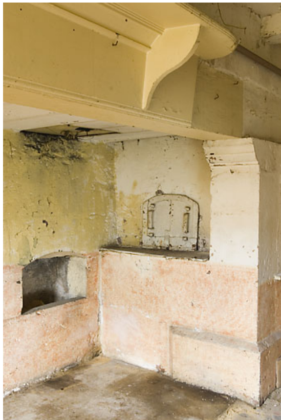
Cuisine du 1er étage : four à pain et cendrier.
