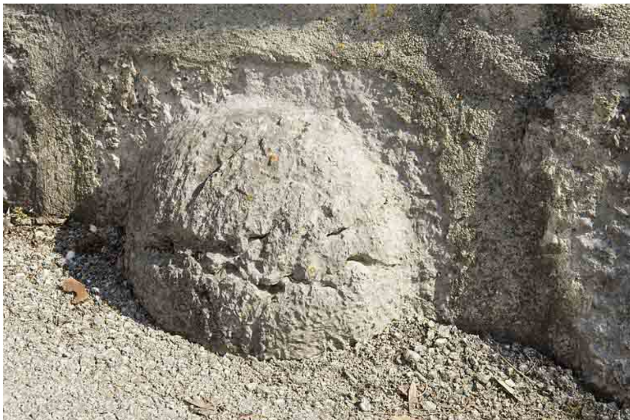
Enceinte au niveau de la maison Billet, détail du bossage. 25, Jougue
