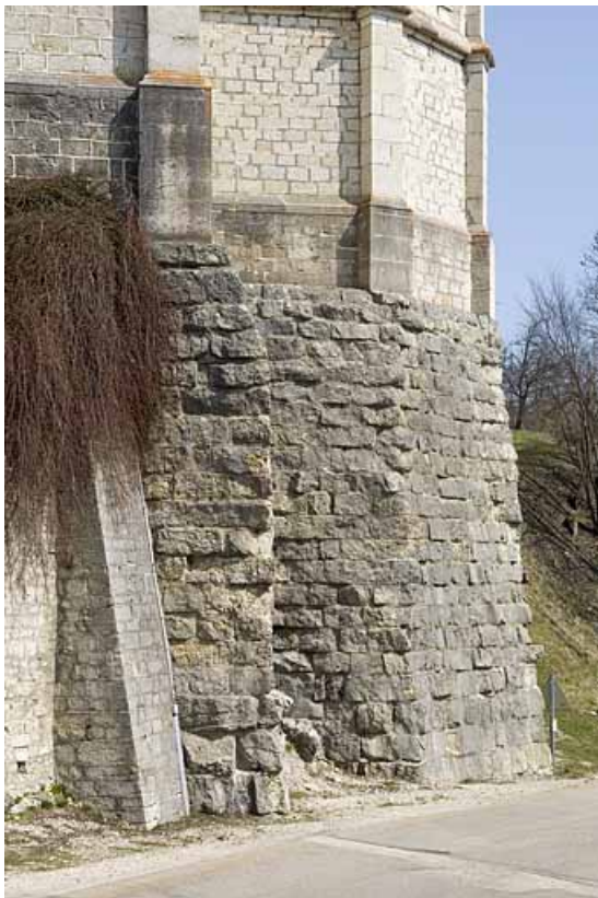
Mur de soutènement crée en 18?? pour asseoir le chevet de l'église paroissiale. 25, Jougue
