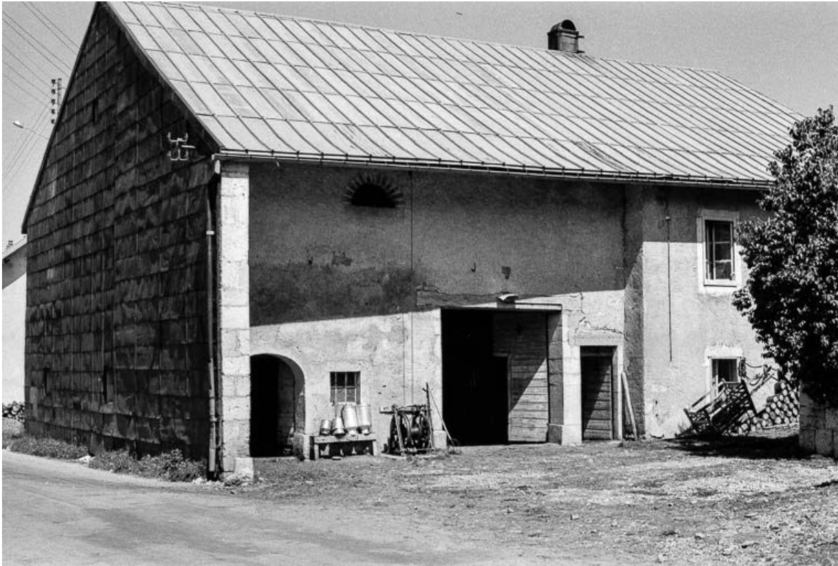
Façade antérieure, grange et écurie. 25, Chaux-Neuve Grande Rue
