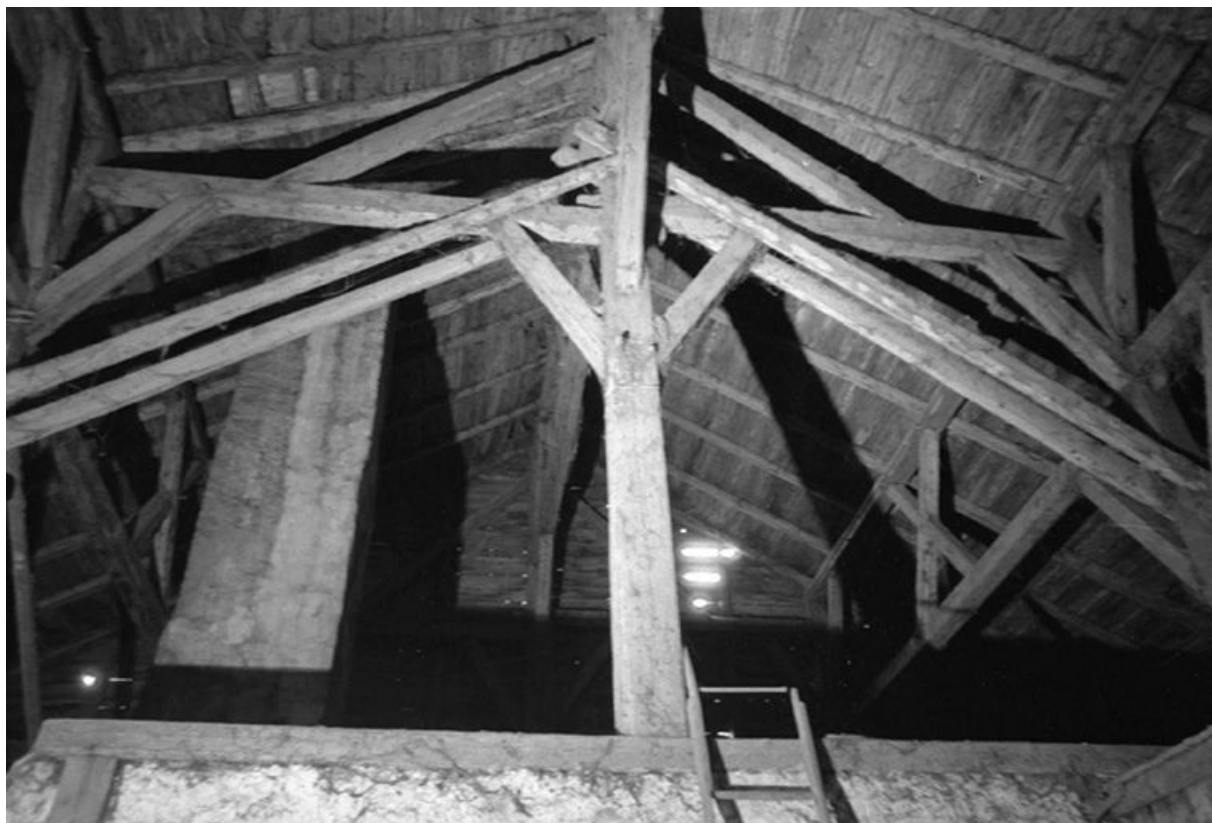
Intérieur : charpente et cheminée.
