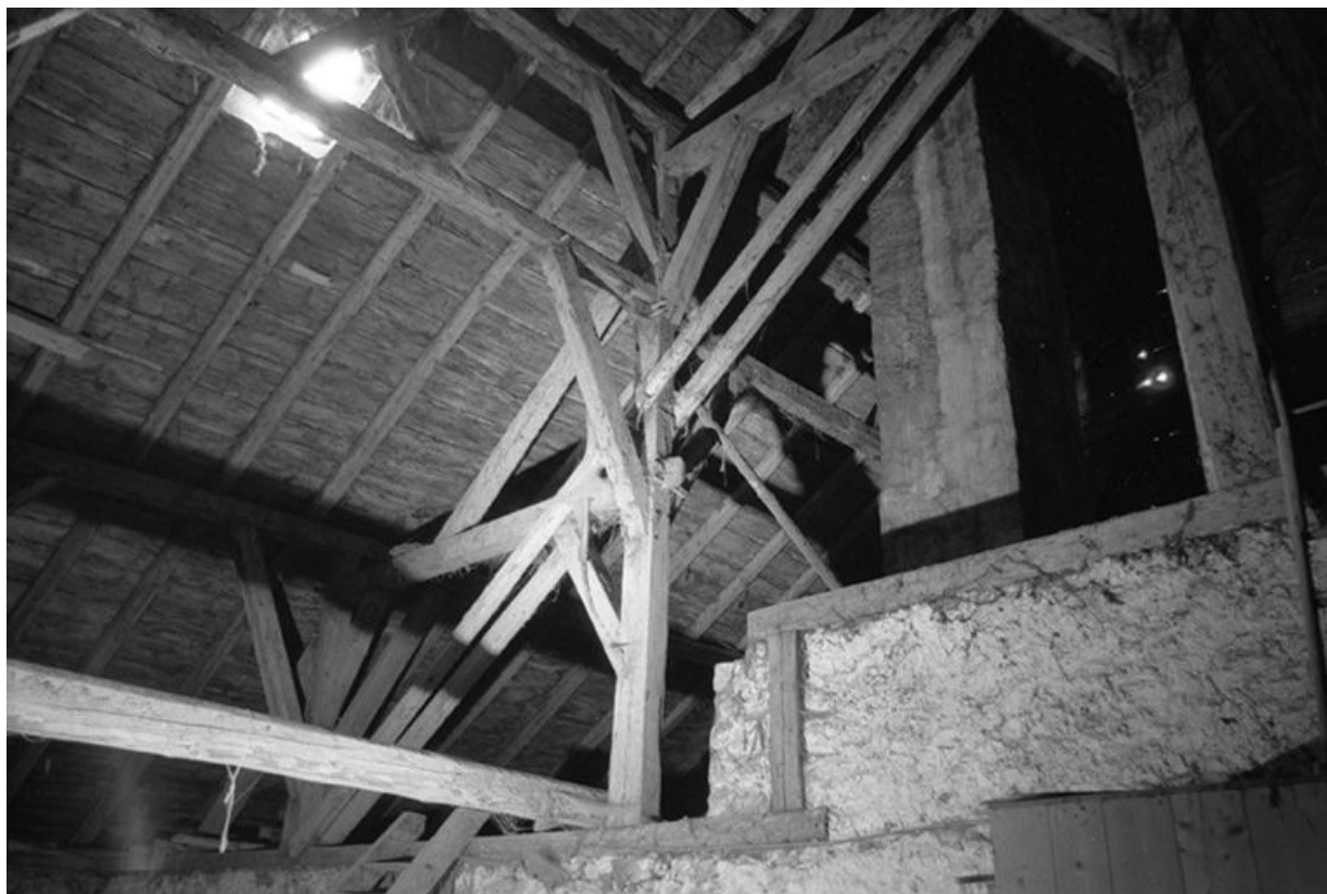
Intérieur : charpente et cheminée.
