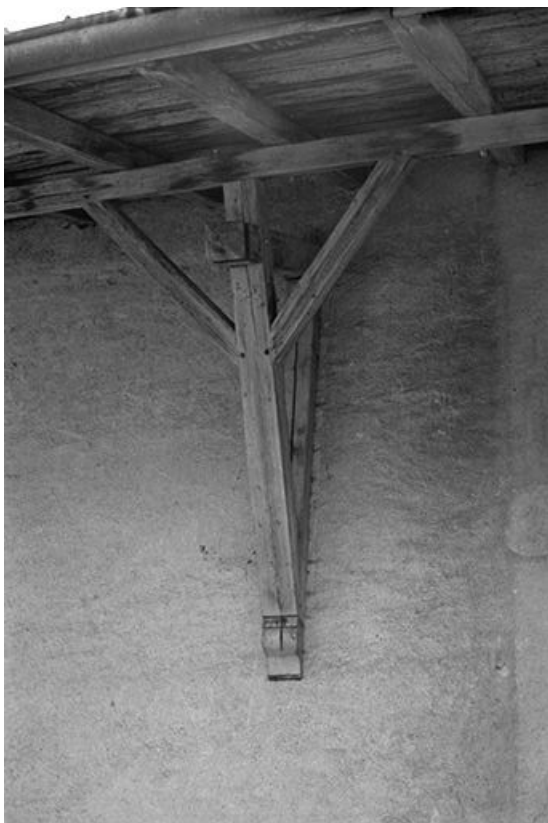
Ferme de 1818, située 11 Grande Rue : extrémité de la pièce de bois doublant le chevron-arbalétrier. 25, Chaux-Neuve
