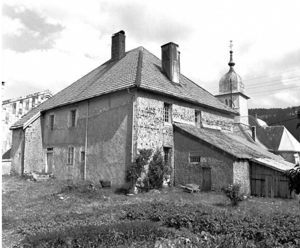
Façades postérieure et latérale gauche. 25, Chapelle-des-Bois, 1 route Principale
