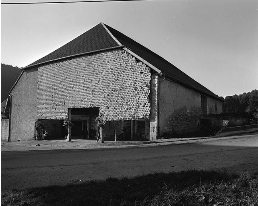
Façade latérale droite sur rue.
