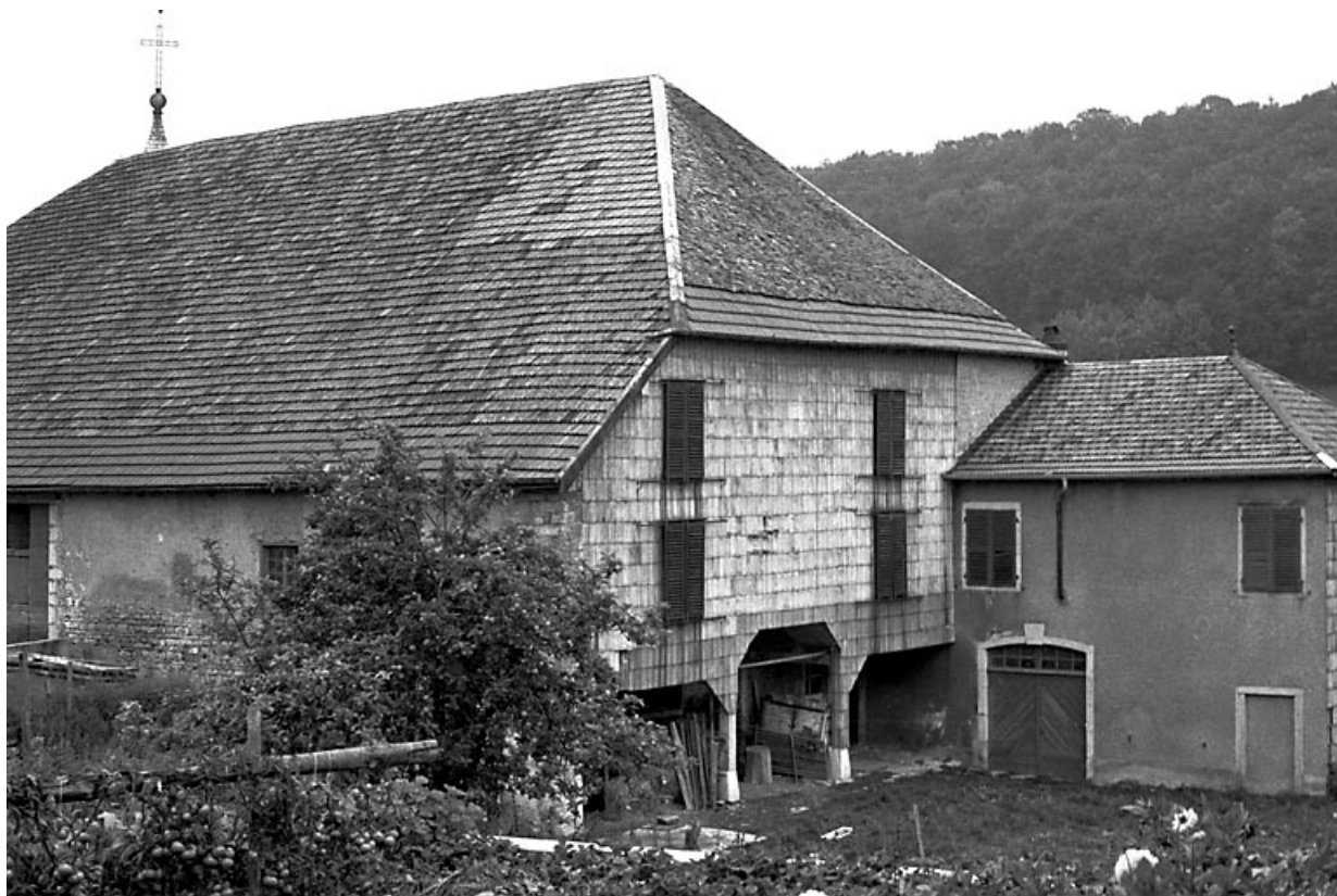
Vue du long pan sur rue et du pignon postérieur.
