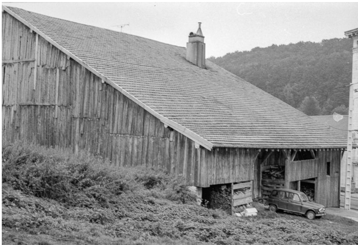
Façades postérieure et latérale gauche. 25, Chapelle-d'Huin rue des Clos
