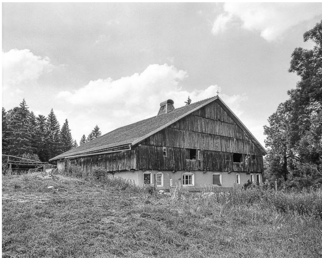
Ferme située au lieu-dit Chez Prenel : façade antérieure et latérale droite 25, Villers-le-Lac
