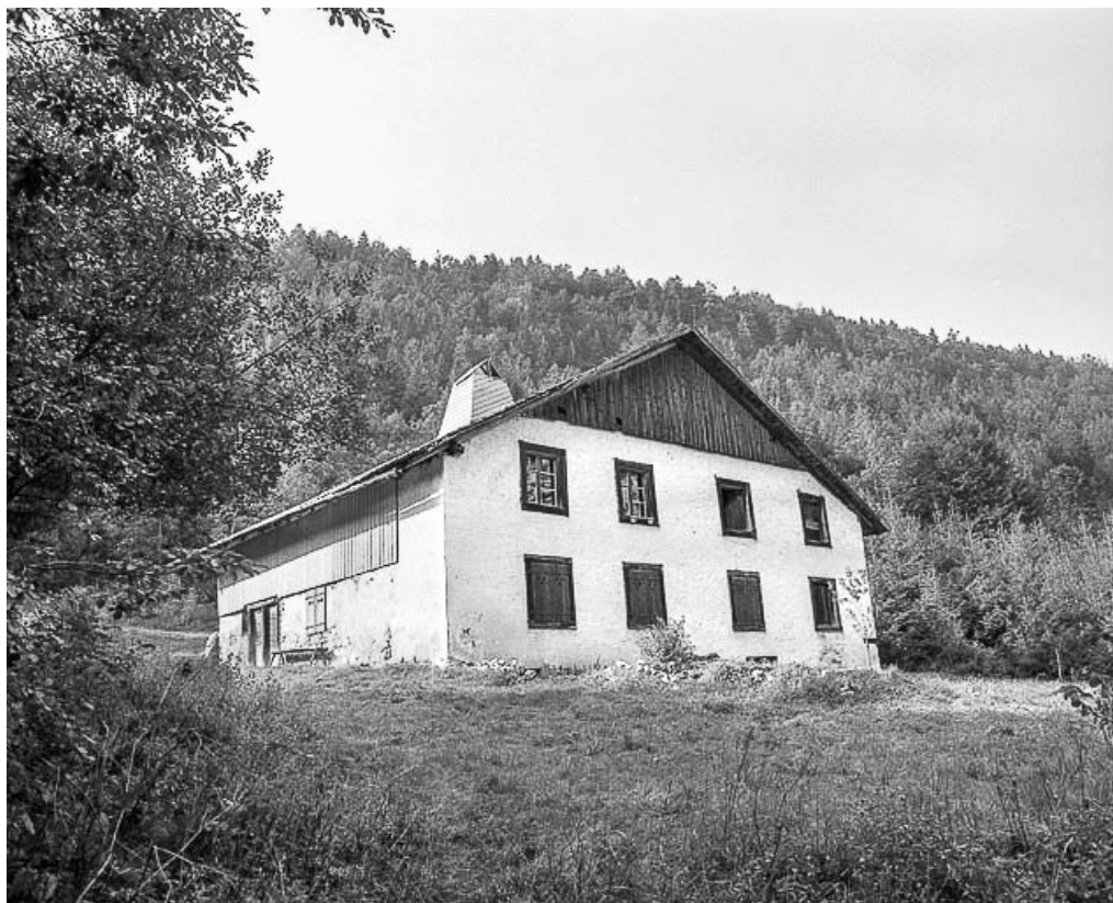
Ferme située au lieu-dit A Gourdavi : façade antérieure et latérale gauche. 25, Villers-le-Lac
