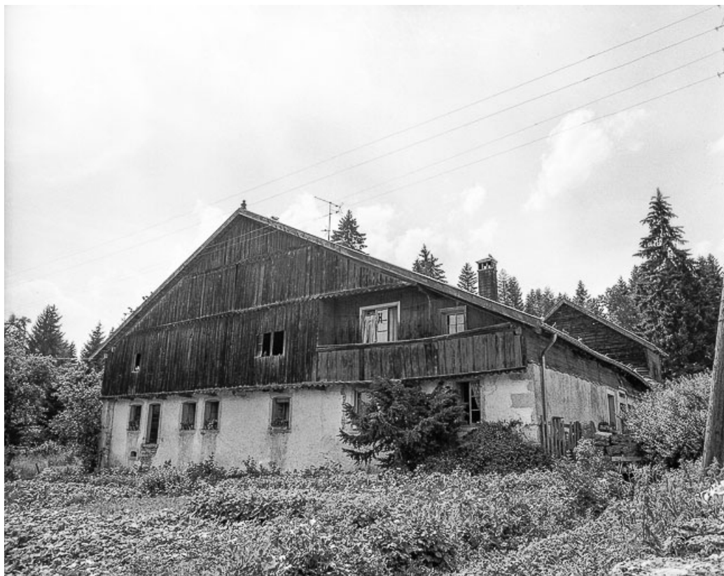
ferme située au lieu-dit Chez Prenel : façade antérieure. 25, Villers-le-Lac
