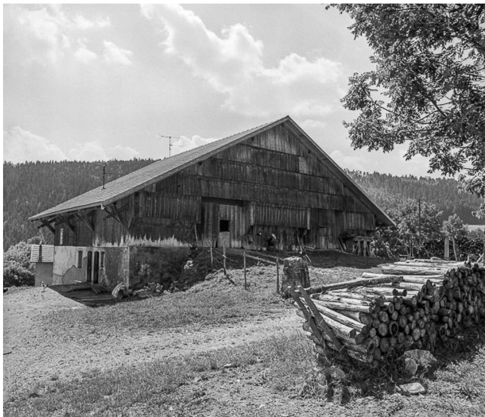
Ferme située au lieu-dit Le Pissoux : façade postérieure. 25, Villers-le-Lac
