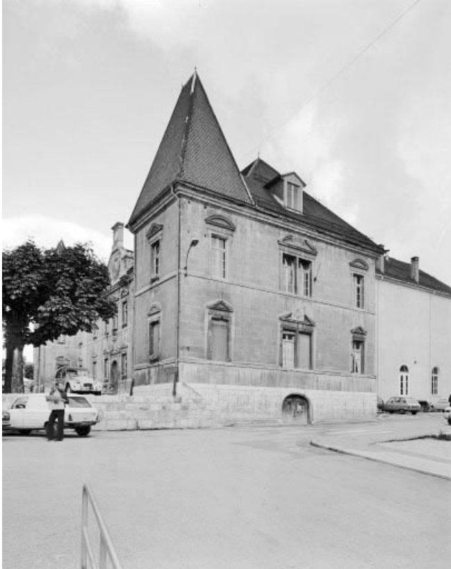
Façade latérale droite.
