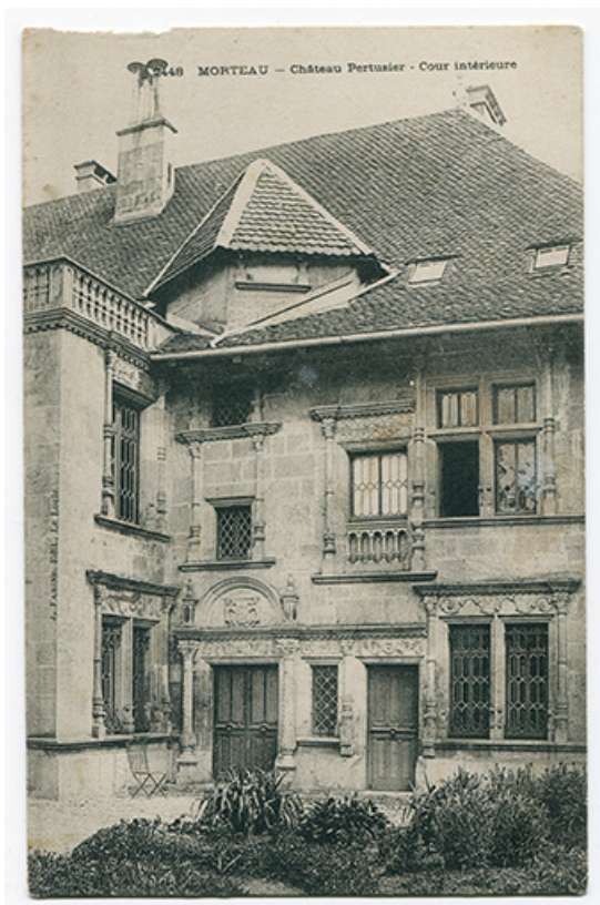
2448 Morteau - Château Pertusier - Cour intérieure, 4e quart 19e siècle. 25, Morteau, 17 rue de la Glapigney
