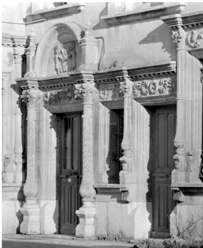
Détail : portail d'entrée.
