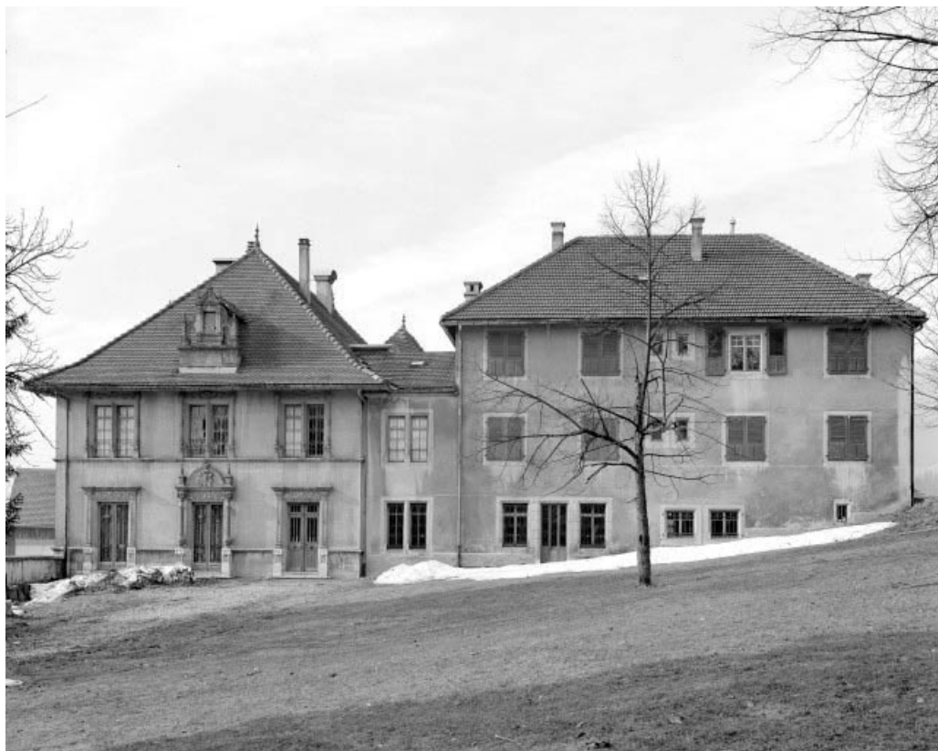
Façade sud est : vue d'ensemble.
