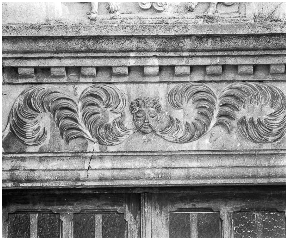
Linteau de la porte d'entrée.
