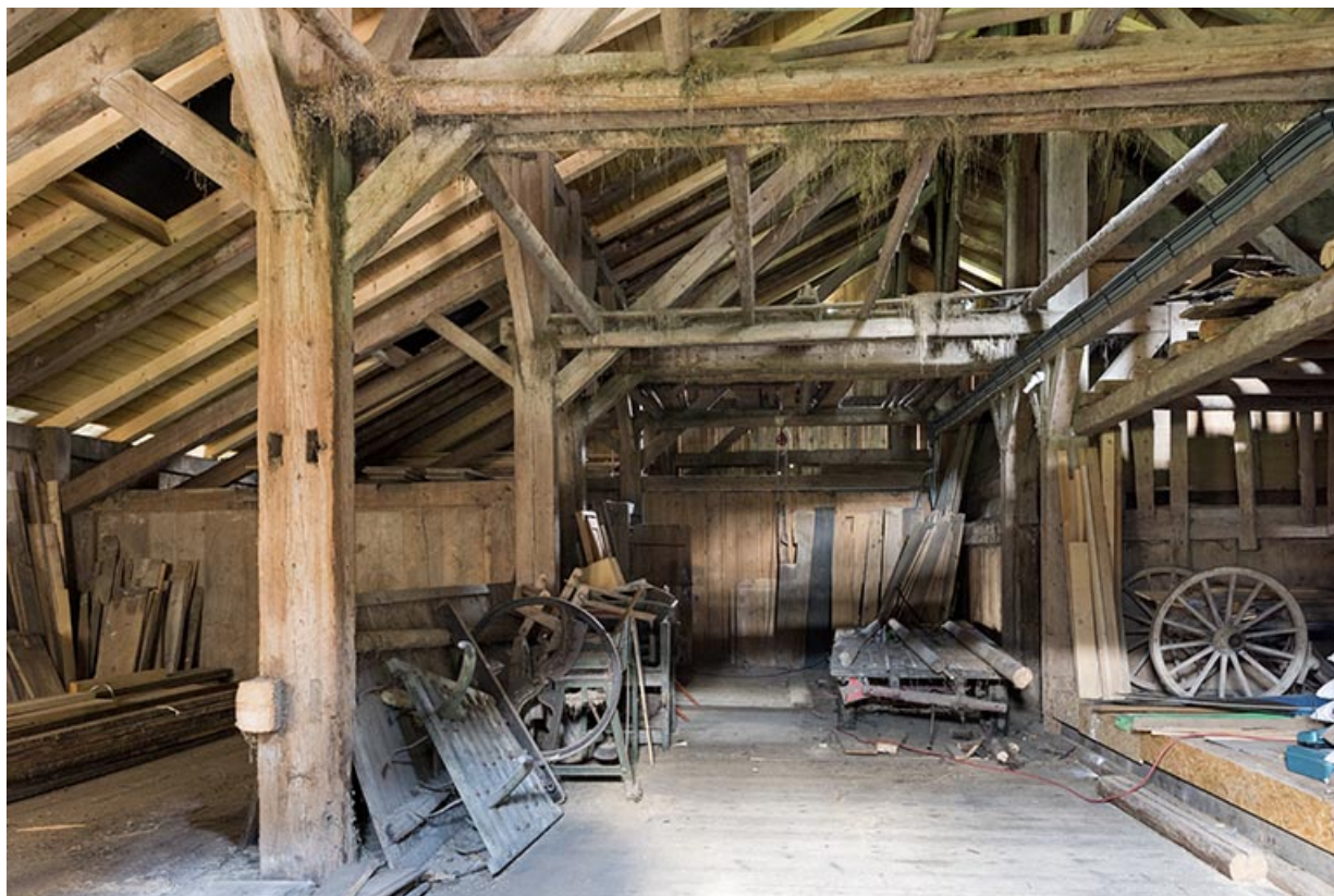
Intérieur de la grange, depuis l'entrée à l'ouest.
