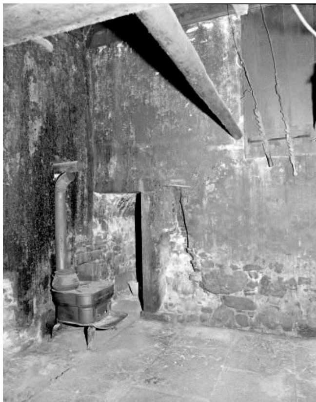
Intérieur : base du petit "tué" et bûcher.
