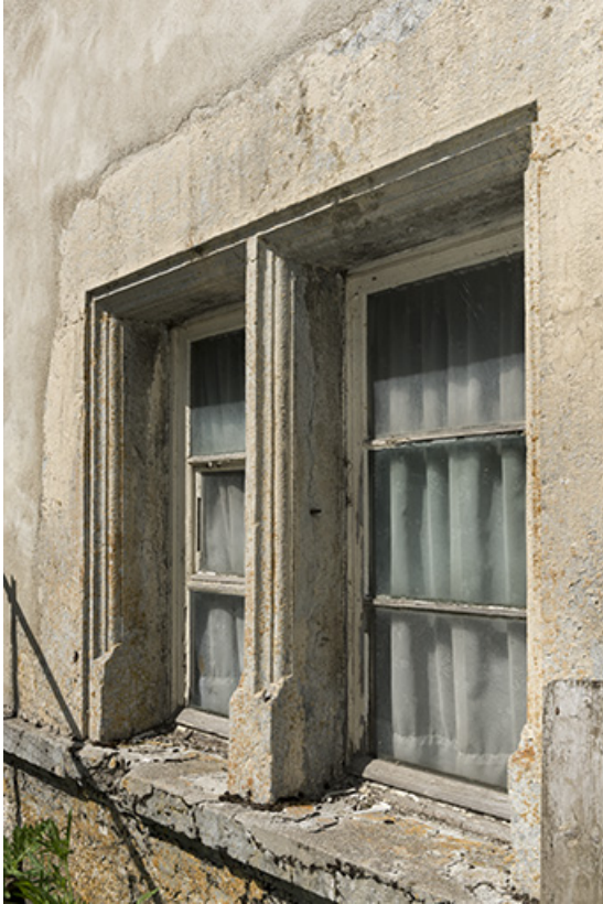
Façade est : fenêtres jumelées à encadrement mouluré.
