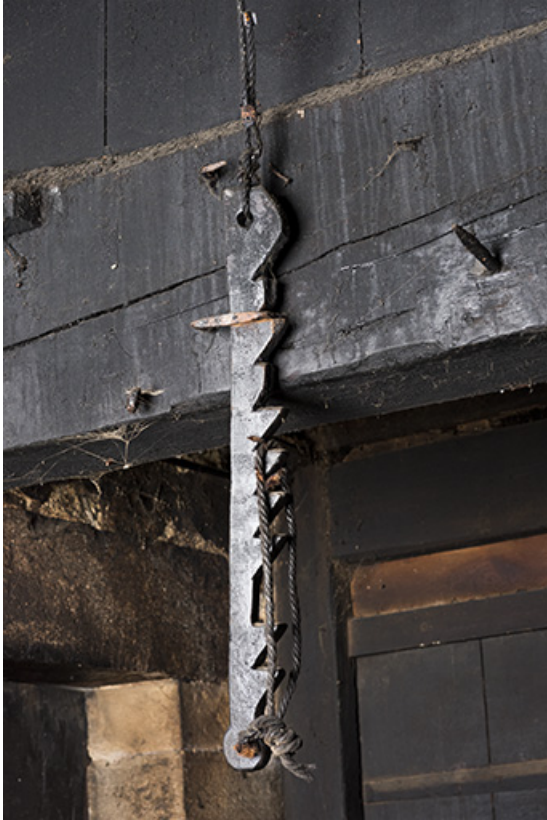
Grand tué : système de fermeture des volets.
