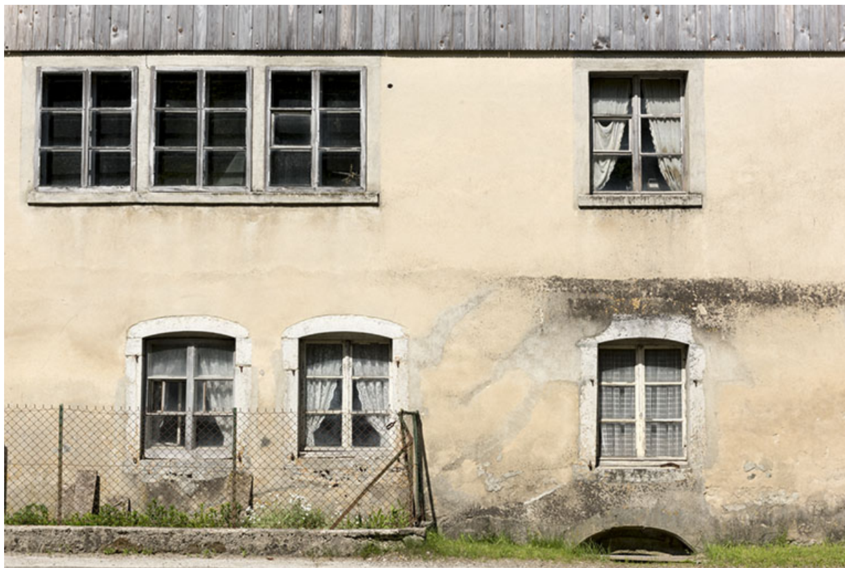
Façade est : porte de la cave au niveau du sol, fenêtres multiples de l'atelier à l'étage.
