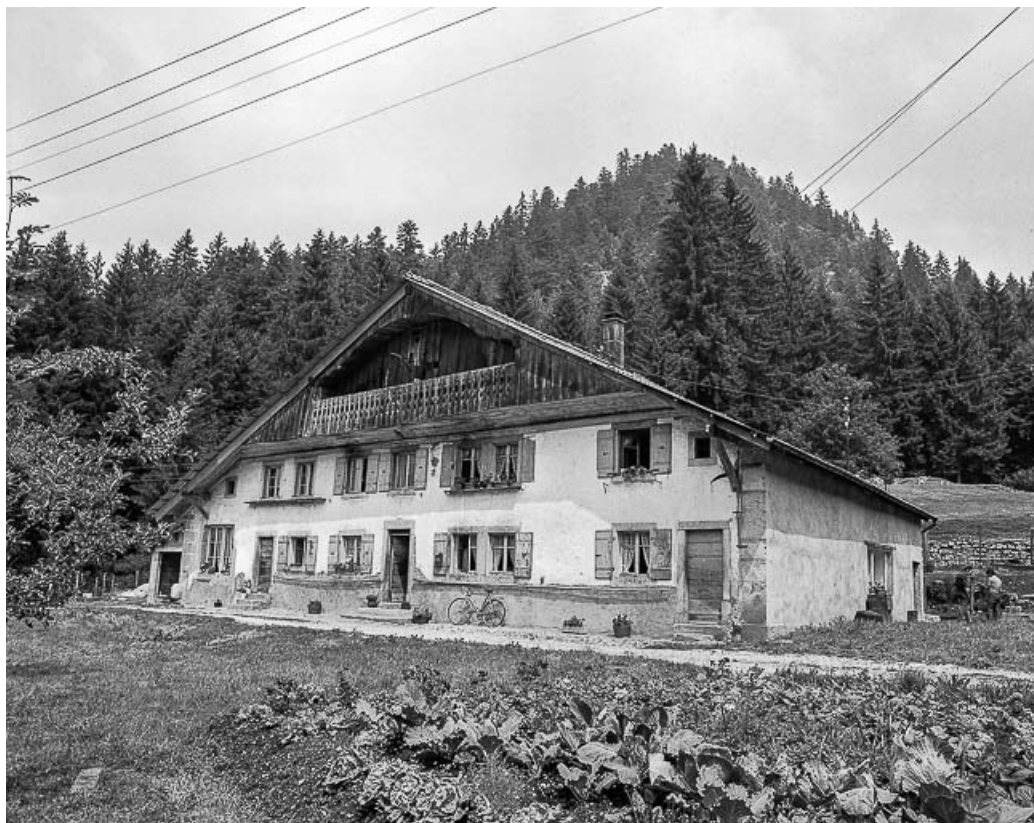
Ferme située au lieu-dit Le Dessus de la Fin, cadastrée B 1-6 : façades antérieure et latérale droite. 25, Les Gras, 6 rue le Dessus de la Fin, lieudit : le Dessus de la Fin
