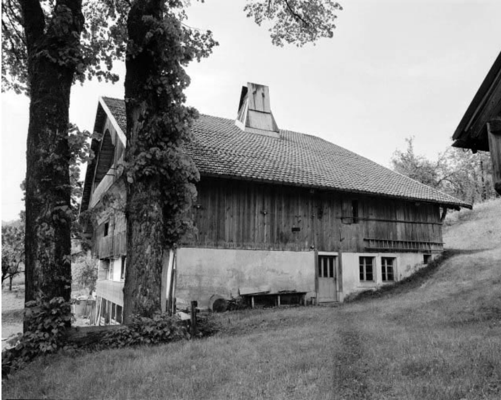
Extérieur : façades antérieure et latérale droite.
