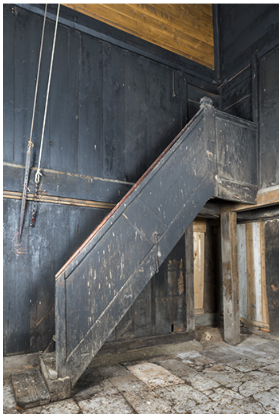
Intérieur, "tué" central : escalier et porte d'accès à la grange.
