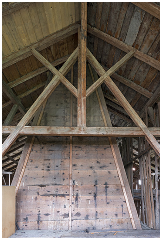
Intérieur, grange : hotte du "tué" central et charpente. 25, Grand'Combe-Châteleu 3e ferme, lieudit : les Cordiers
