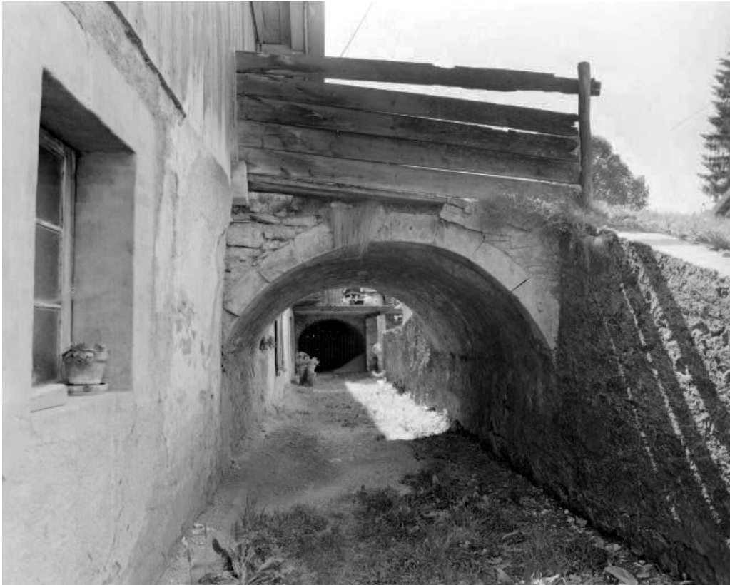
Façade antérieure : ponts de granges.
