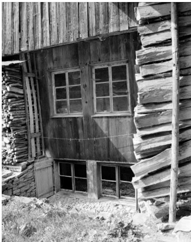
Façade postérieure : fenêtre de la cuisine.
