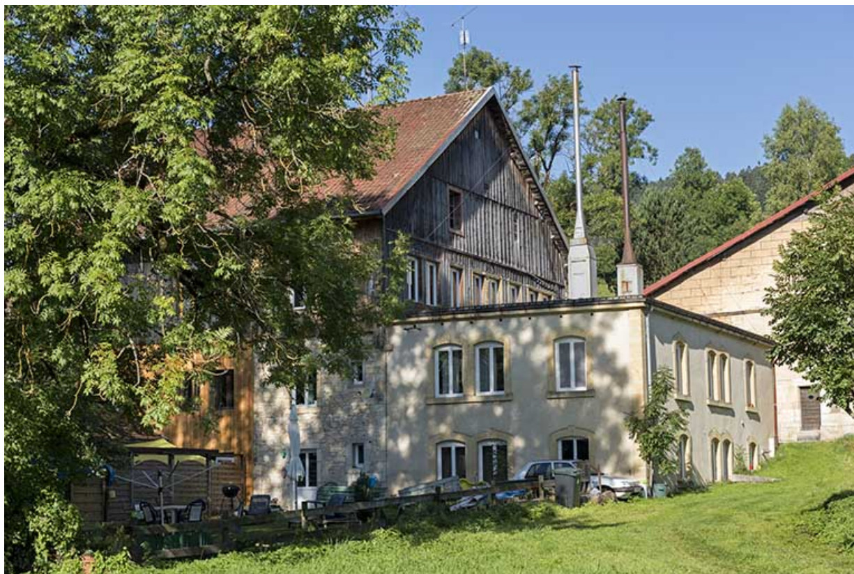
Extension nord, vue de l'est.
