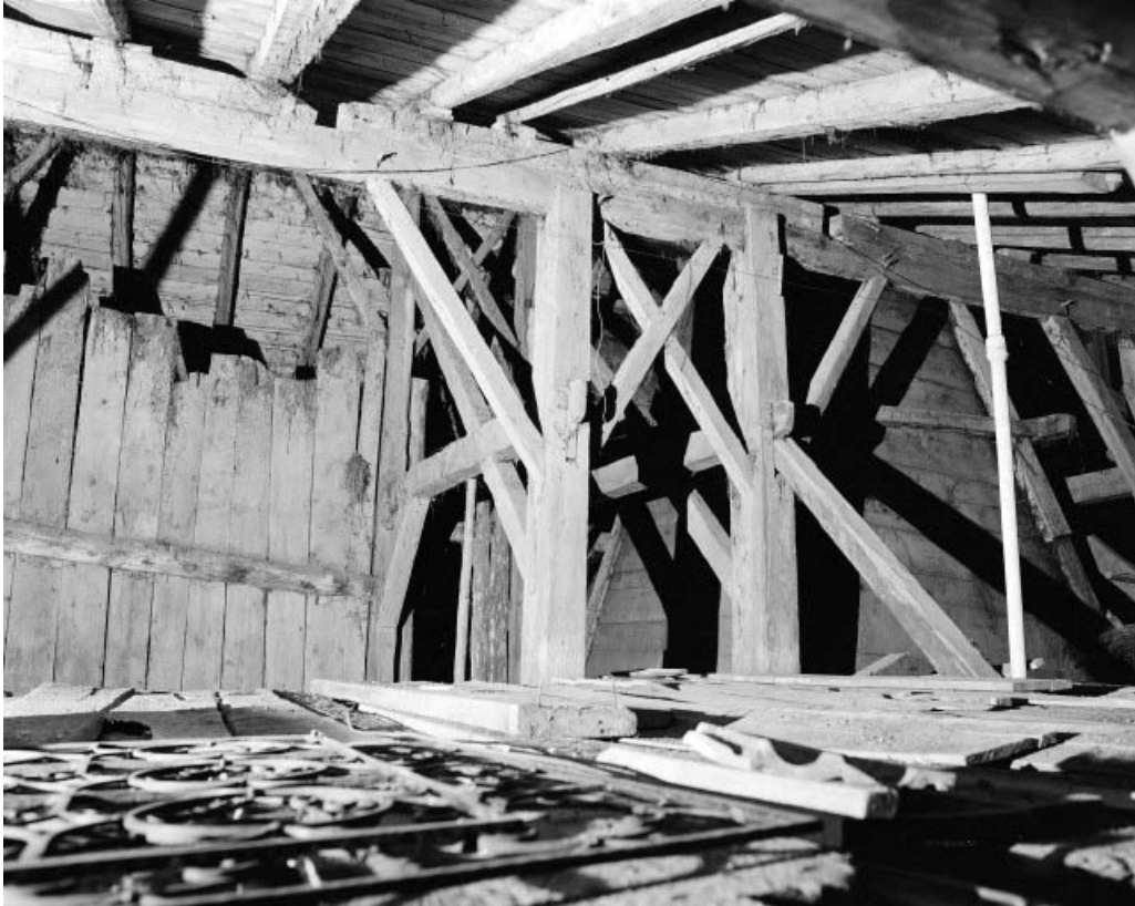
Intérieur : combles, fermes de charpente jumelées en arrière des "tués" au niveau d'une panne. 25, Grand'Combe-Châteleu, lieudit : Bas de Grand-Combe
