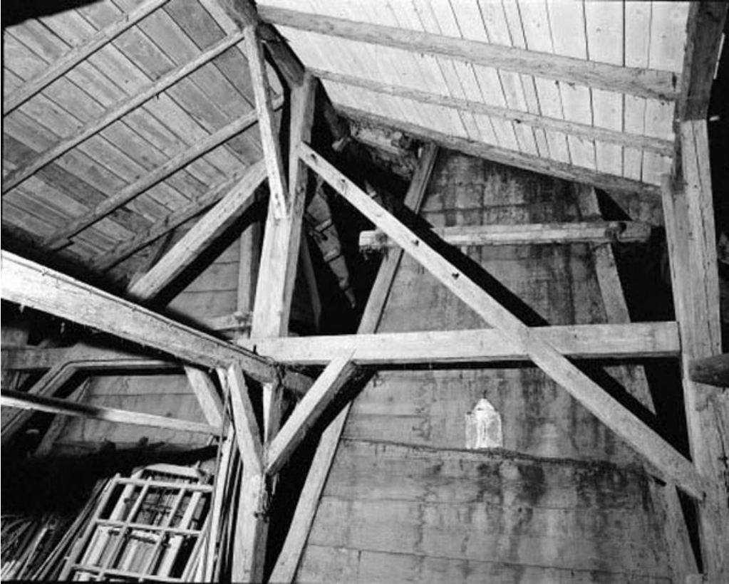
Intérieur : combles, fermes, charpente, hottes des "tués".
