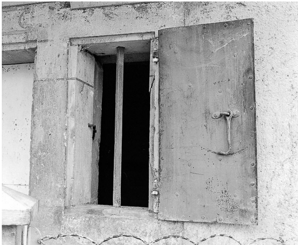
Façade antérieure : volet ouvert de la voûte.
