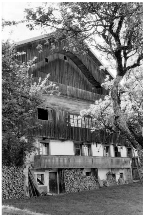
Extérieur : façade antérieure.
