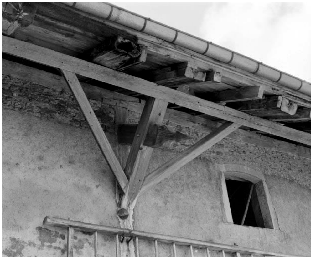
Détail: extrémité d'arbalétrier et assemblage de charpente.
