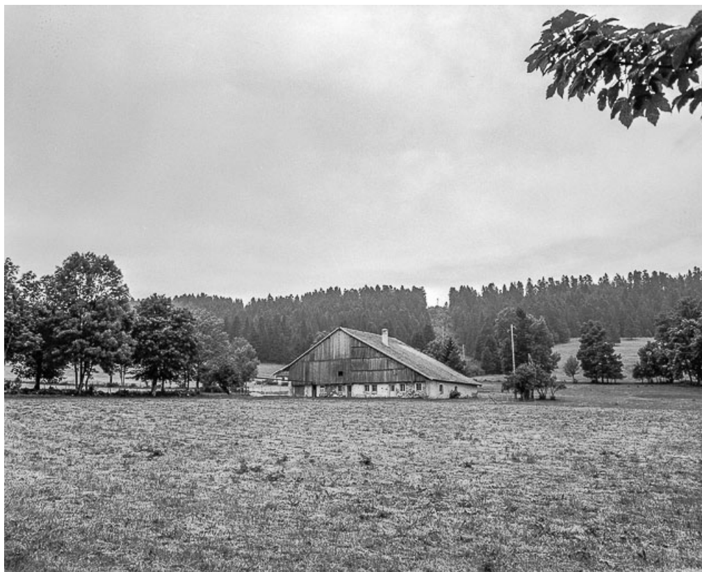
Ferme située au lieu-dit Combe d'Abondance, cadastrée B1 177 : vue d'ensemble. 25, Les Combes
