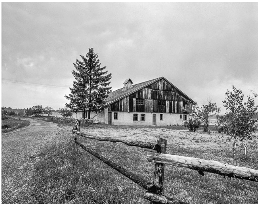
Ferme située au lieu-dit Combe d'Abondance, cadastrée B2 247 : façades postérieure et latérale droite. 25, Les Combes
