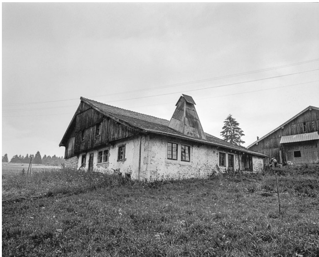
Ferme située au lieu-dit Remonot, cadastrée AC 50 : façades antérieure et latérale droite. 25, Les Combes
