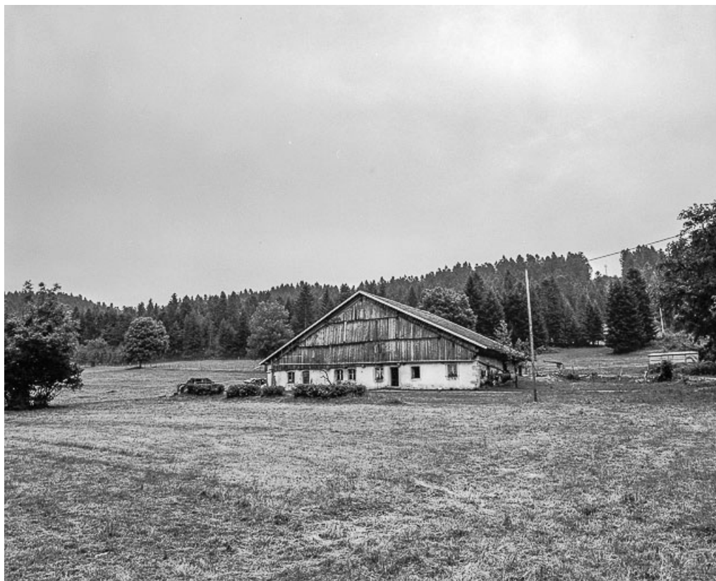
Ferme située au lieu-dit Combe d'Abondance, cadastrée B1 139 : vue d'ensemble. 25, Les Combes
