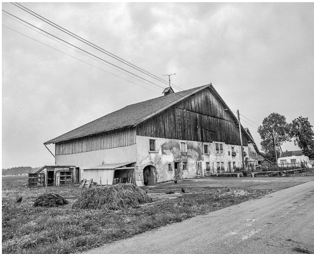
Ferme située au lieu-dit Combe d'Abondance , cadastrée B2 241 : façades antérieure et latérale gauche. 25, Les Combes
