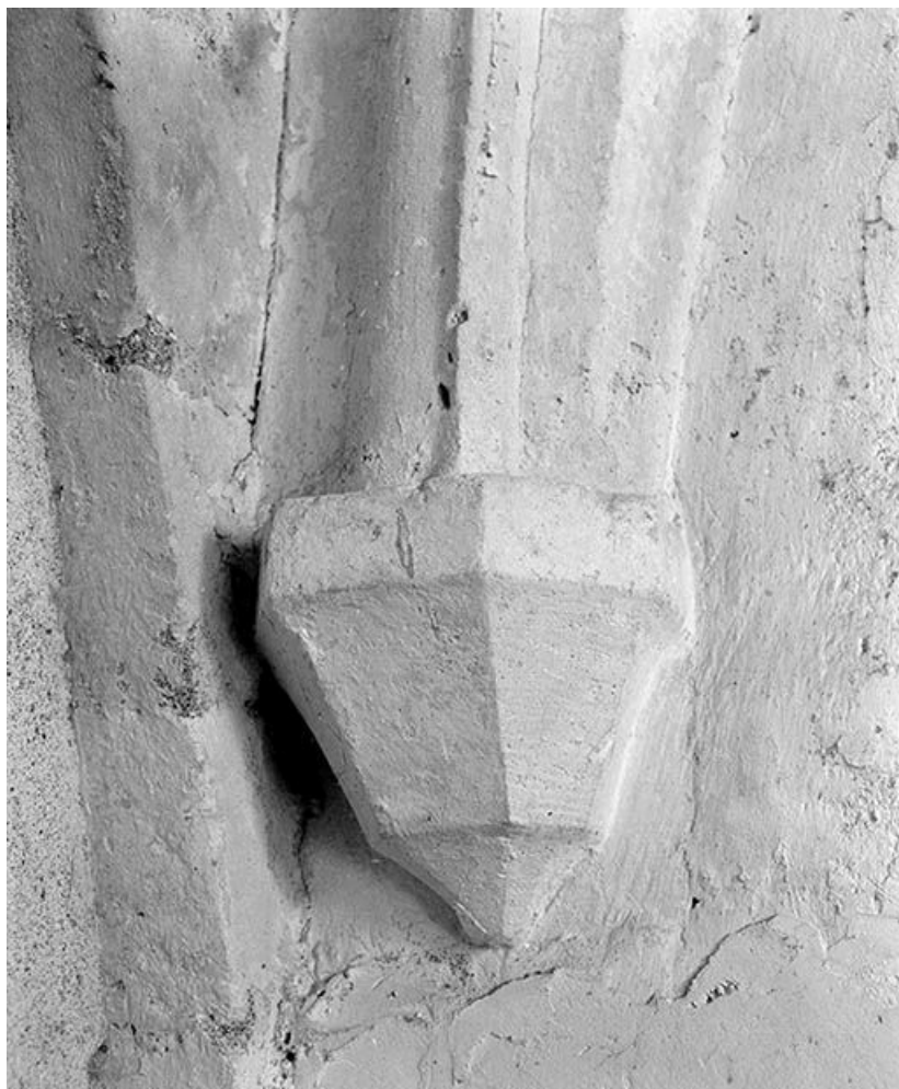
Clocher, niveau inférieur : culot postérieur gauche.
