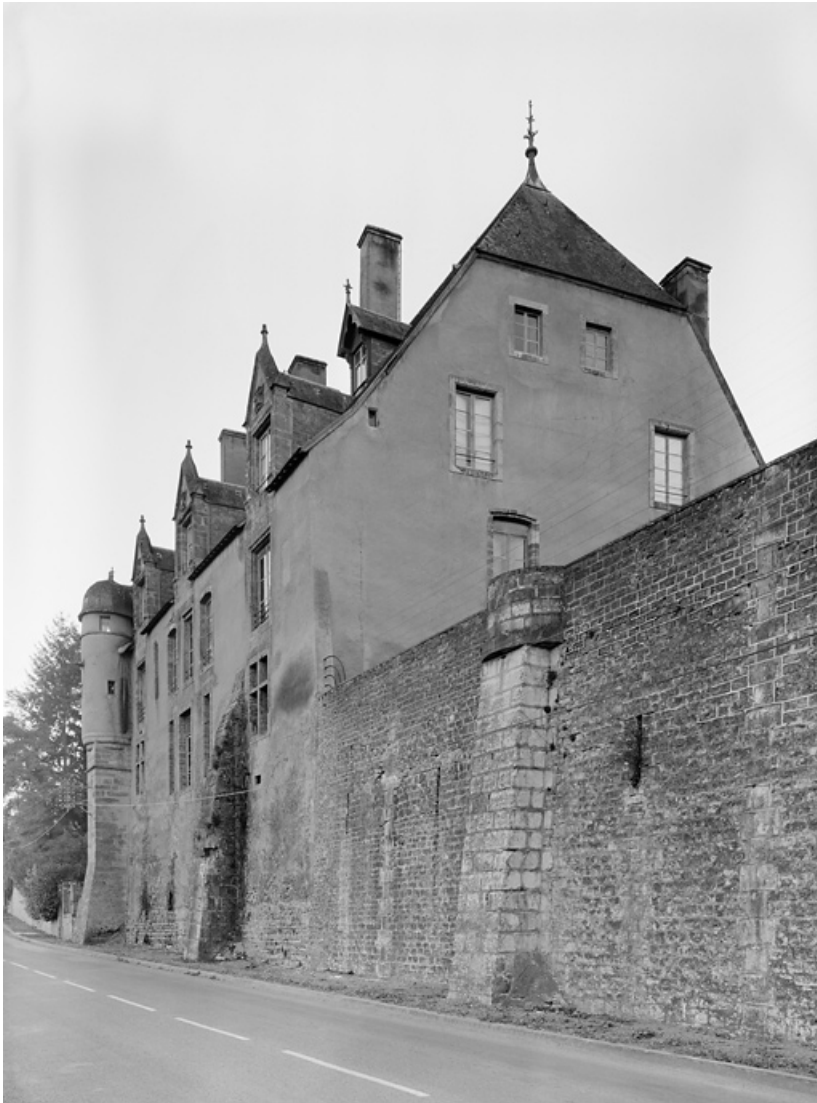
Le corps de logis vu de la route.
