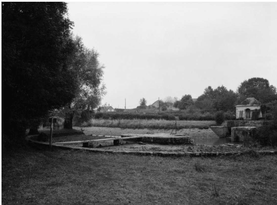
Le déversoir de superficie et la maison du barragiste en aval du site d'écluse.
