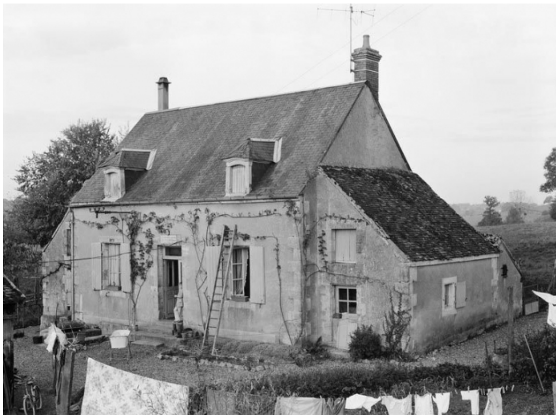
Vue d'ensemble de la maison éclusière. 58, Aulun, lieudit : bief 06 du versant Loire
