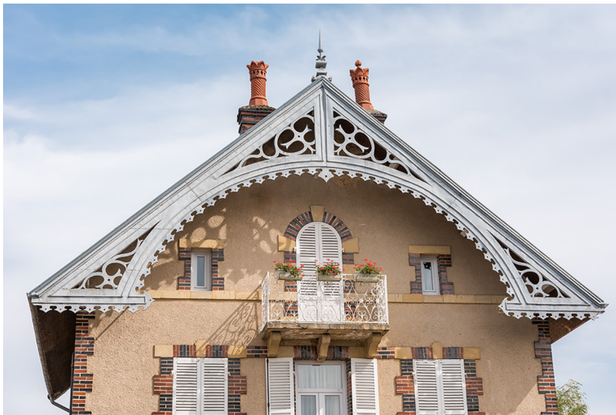
Pignon protégé par une large saillie de rive décorée d'un lambrequin métallique découpé.
