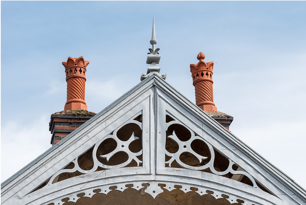
Lambrequin métallique découpé imitant un décor de menuiserie et cheminées ornées.
