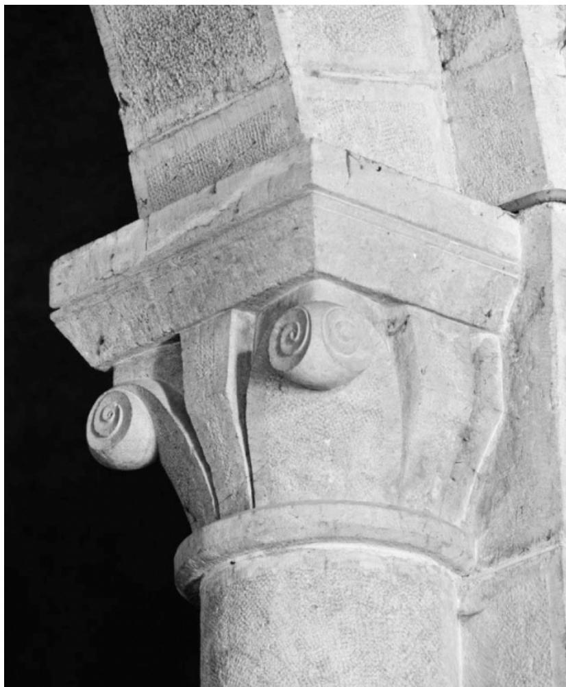
Détail du chapiteau de la troisième colonne de droite de la nef. 58, Isenay
